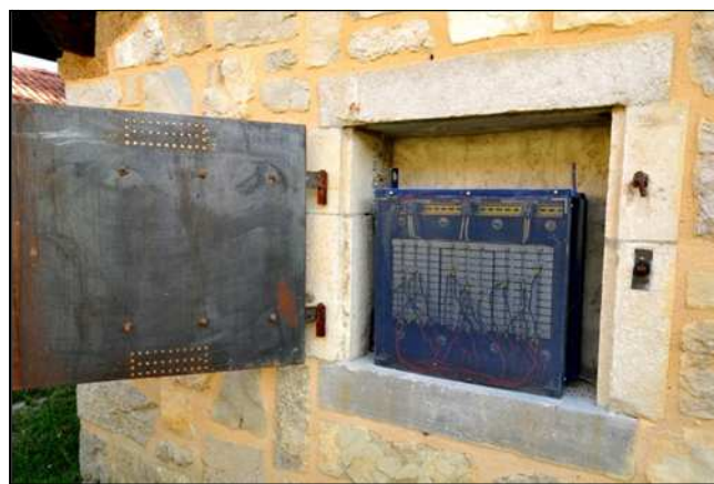
Pose en extérieur
