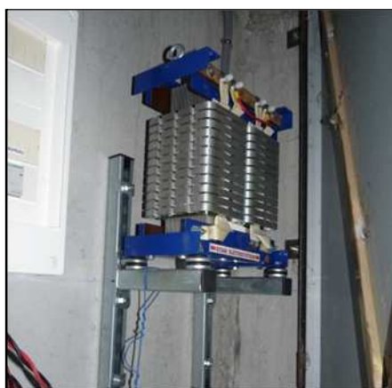
Pose au sous-sol sur une chaise
