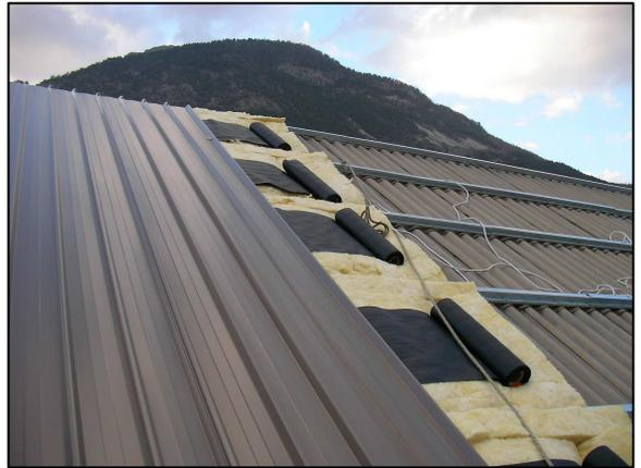
**1-** Mise en place des chevrons de fixation de la nouvelle toiture sur l'ancien revêtement.
